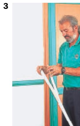
**L'**installation sous baguette est la technique utilisée pour des aménagements après construction, sans encastrement. Les baguettes — que l'on appelle plutôt des moulures — sont principalement en plastique même s'il en existe encore en bois. Elles sont proposées en différentes largeurs (20 à 75 mm) selon le nombre de fils à faire passer, et vont jusqu'à la plinthe de 110 mm de hauteur qui permet le passage d'une quarantaine de fils d'électricité, de téléphone, d'antenne, ou d'informatique.
