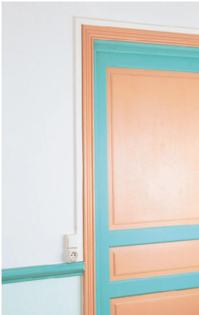
Les canalisations électriques sont disposées dans les moulures, et l'appareillage apparent (prises, inters) est posé le long de celles-ci. On peut choisir entre des moulures standard et des "systèmes" de moulures avec cadres d'intégration de l'appareillage, accessoires de raccordement et de finition. Avant l'installation proprement dite, réaliser un schéma de passage des fils
